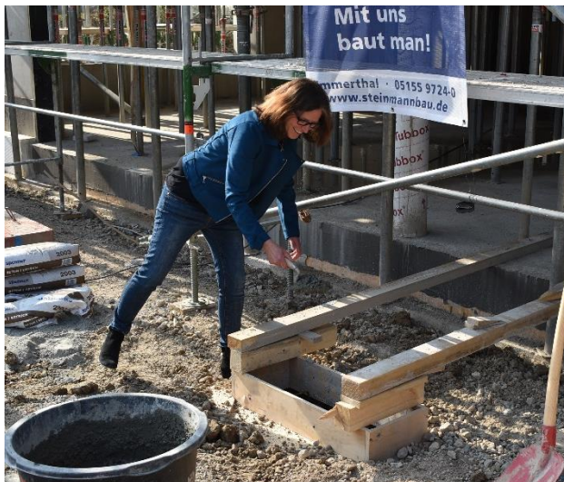
Abbildung: Quartiersmanagerin bei der Grundsteinlegung im März 2022
