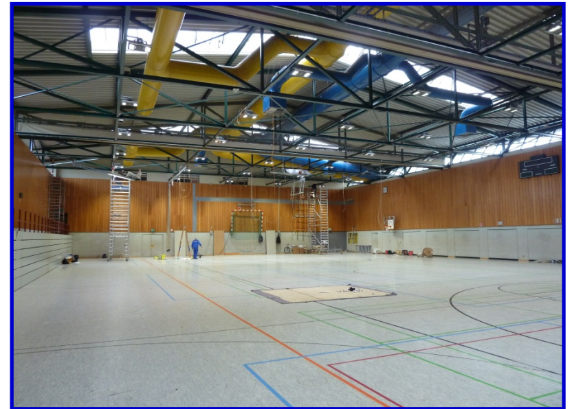
Neue Beleuchtungsanlage von Siteco mit dimmbaren elektronischen Vorschaltgeräten Dali EVG
