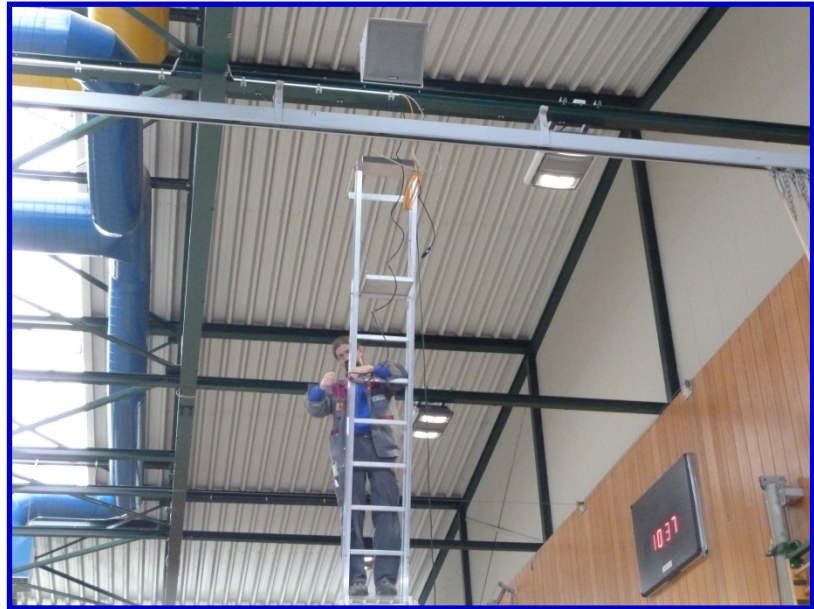
Einbau der Siteco LED Deckenstrahler
